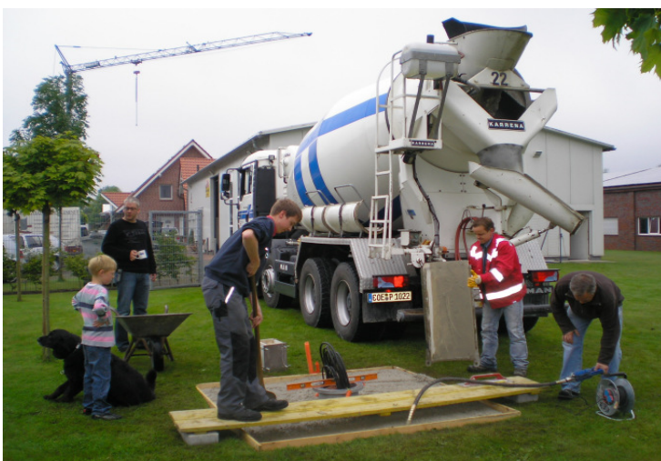
Erstellung des Betonfundaments, Gewicht uber 7 Tonnen
