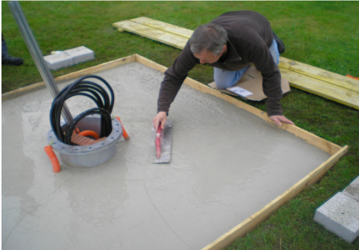
Glattstrich der Oberfläche
