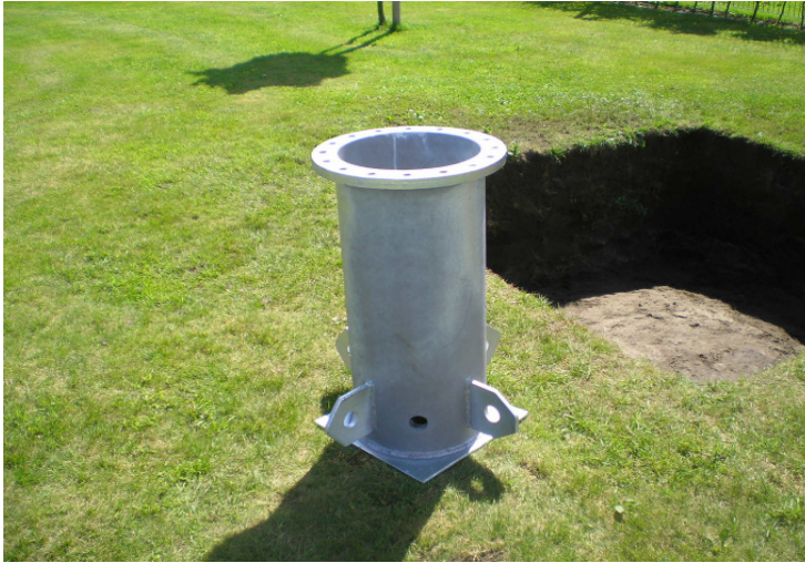
Tiefbauarbeiten, 2,0m x 2,0m x 0,8m
