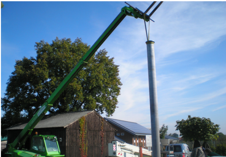
Aufstellung Mast ca. 450kg
