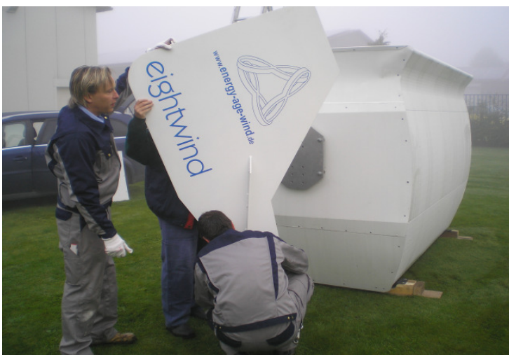
Montage der Windrichtungsfahne
